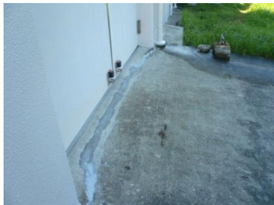
(1) 建家機器搬入口のコンクリート部 クラックの復旧
