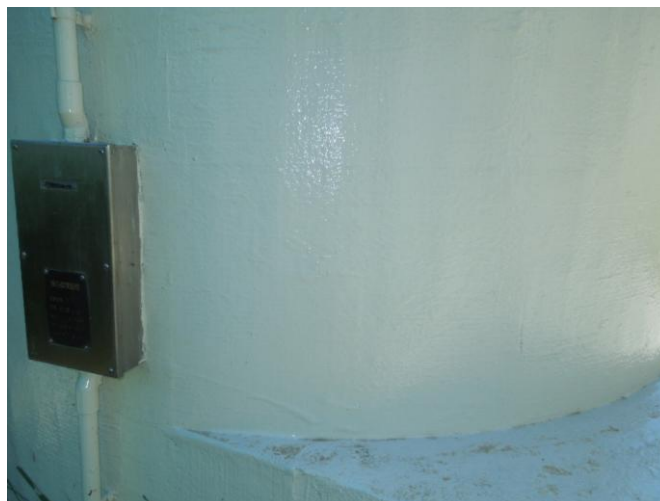
図3-4 補修後のJRR-4排気筒
