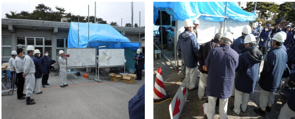
図 2-3 工務技術部による復旧作業打合せ状況
