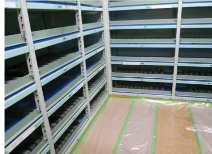
(2) 燃料キャビネットの復旧
