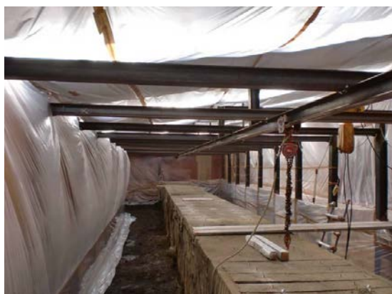
共同溝（南北方向）撤去前
