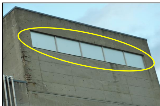
3階南側窓ガラス補修後の状況
