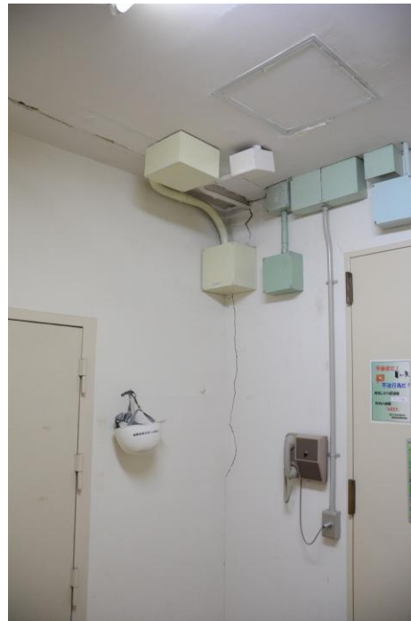
図 2-24 JRR-4 RI 貯蔵庫及び通路の天井と壁面のひび
