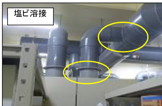
フード排気ダクト溶接補修後の状況
