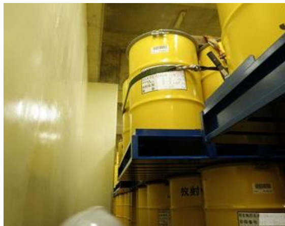
ドラム缶固縛による仮復旧状況 (廃棄物保管棟・Ⅱ, 2階)
