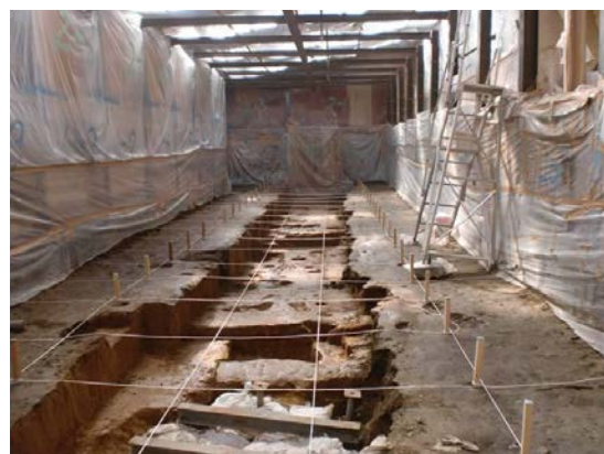
共同溝（南北方向）撤去後
