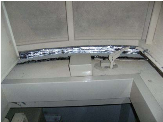
燃料貯蔵庫の建家つなぎ部の補修後の状況（建家内部）
