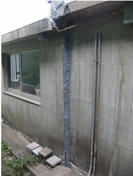
放射性廃液貯槽室の建家つなぎ部の補修後の状況（建家外部）
