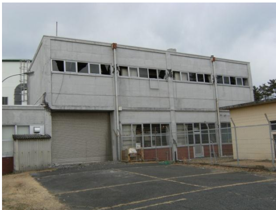
15tonクレーン室の外観
