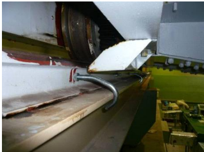
(5) 天井クレーンフックボルトの復旧
