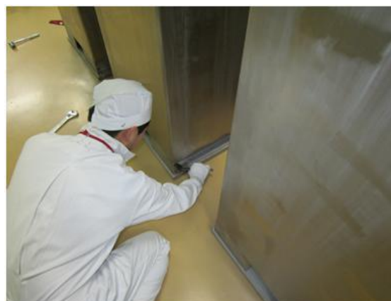
(2) アンカーボルトの緩み確認
