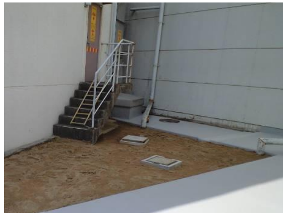
図3-3 JRR-3原子炉建家と実験利用棟の間の地盤陥没（補修前後）
