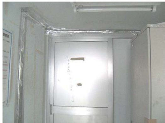
放射性廃液貯槽室の建家つなぎ部補修後の状況（建家内部）
