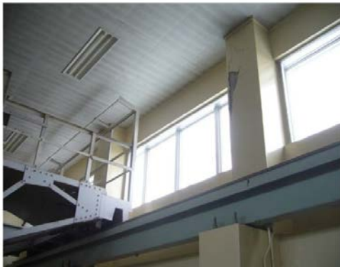
冶金サービスルーム柱の一部損傷
