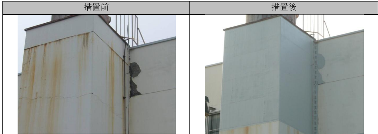
主排気筒脚部の亀裂に係る措置状況
