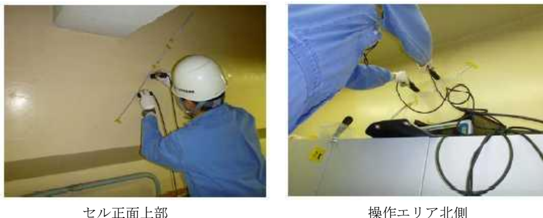
図 3-23 クラック超音波探査状況
