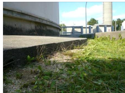
(6) 炉室周辺地盤陥没の復旧
