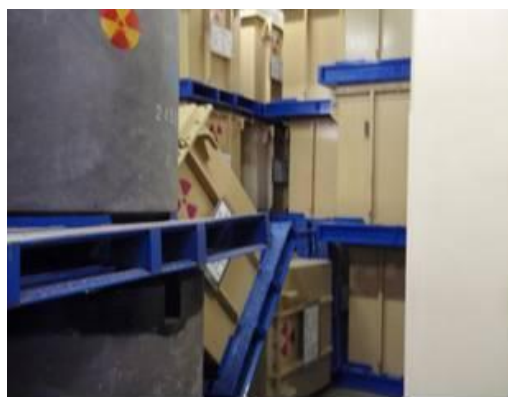
鋼製角型容器の荷崩れの状況
