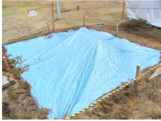
コンクリートダクトの応急処置状況
