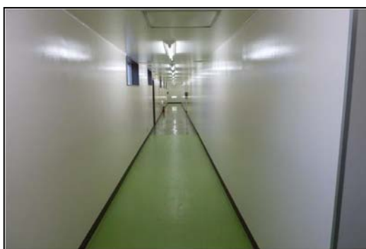
1階廊下補修後の状況
