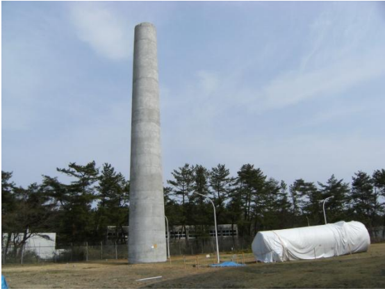
一部が倒壊した排気筒の応急処置状況
