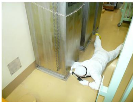
(1) アンカーボルトの変形確認
