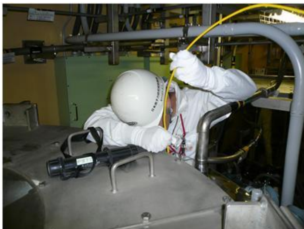
(3) ファイバースコープによる機器内部確認
