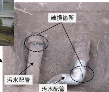
污水用埋設配管の破損に係る措置状況
