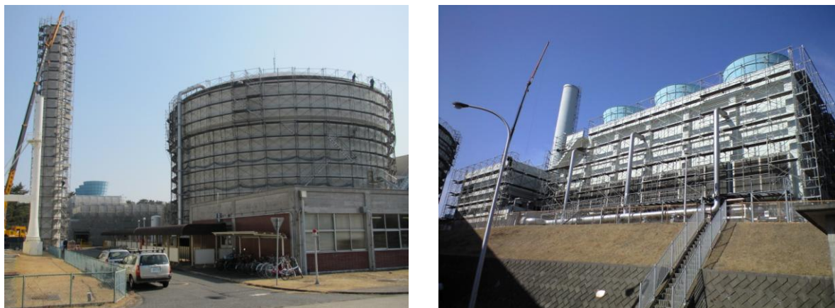
図3-2 JRR-3原子炉建家、排気筒及び冷却塔の補修（足場組立）
