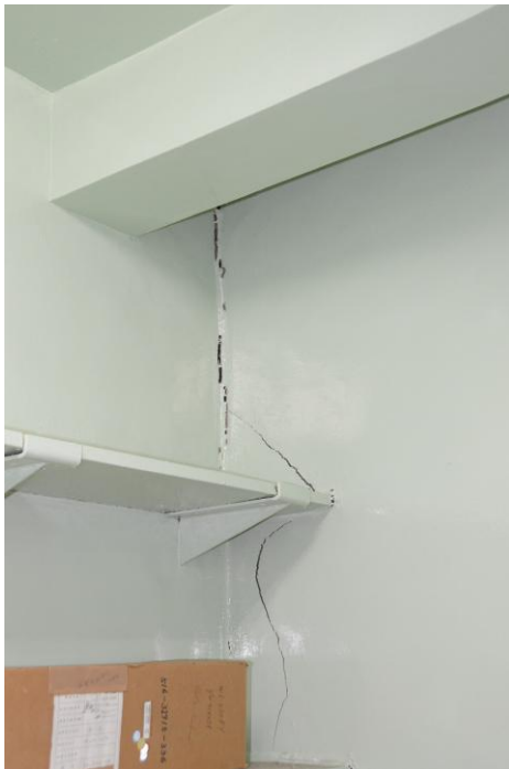
図 2-24 JRR-4 RI 貯蔵庫及び通路の天井と壁面のひび
