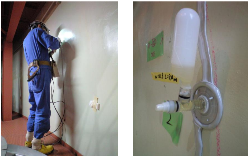
図3-1 JRR-3原子炉建家内のひび割れ調査及びエポキシ樹脂注入
