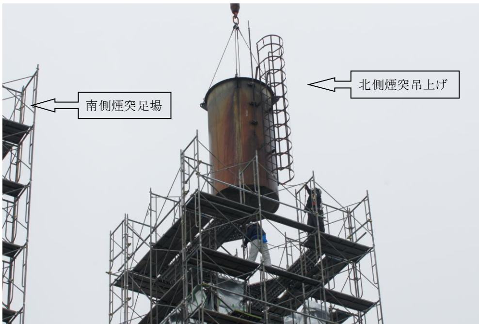
図 2-48 第 2 ボイラーの北側煙突切断
