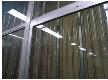
(4) 制御室のガラス窓の復旧
