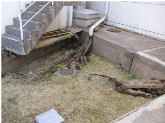
図3-3 JRR-3原子炉建家と実験利用棟の間の地盤陥没（補修前後）
